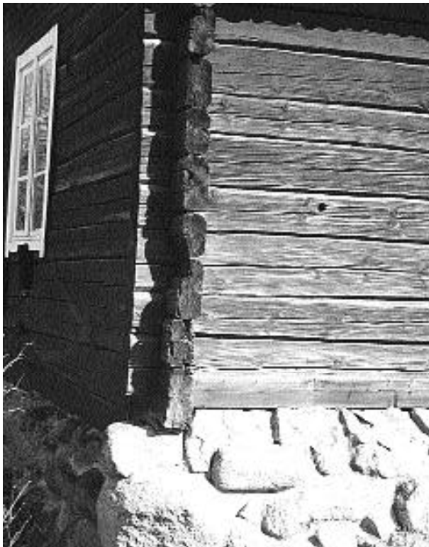
1. ábra Boronafalas épület indítása a talajon (svéd példa)
