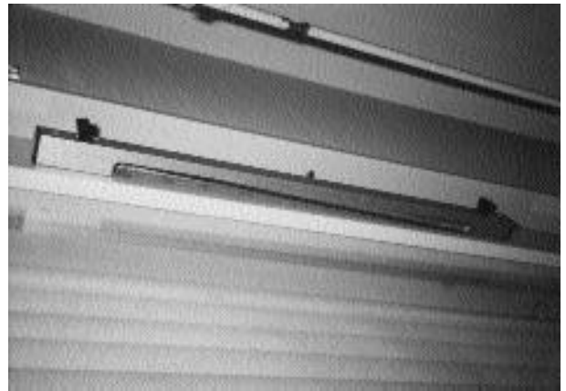
Az ablakszárny felső részére szerelt szellőző baloldalt nyitott, jobboldalt zárt állapotban.
