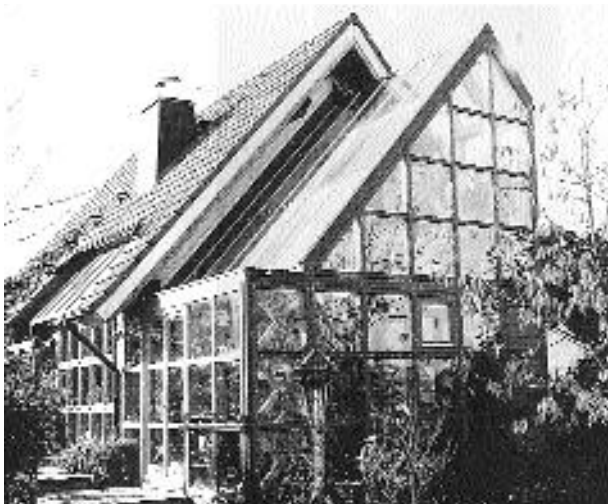
13. ábra Épületbővítés télikerttel (beépített, illetve eredeti állapot)
